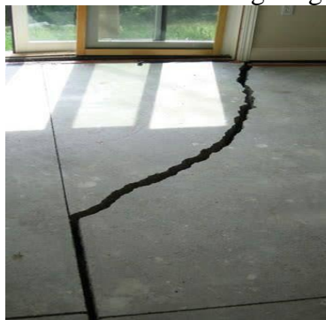
Fig. 1.4. Floor crack
